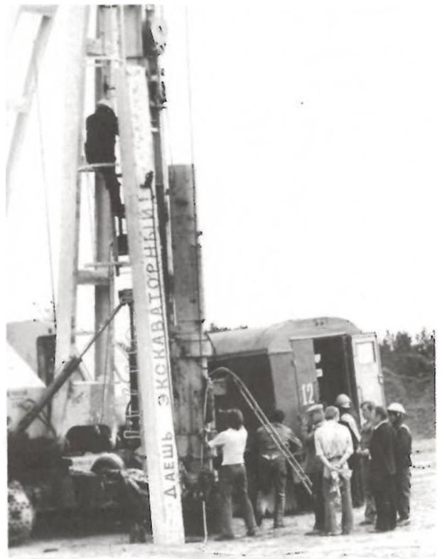
Первая свая на строительстве завода тяжелых экскаваторов
