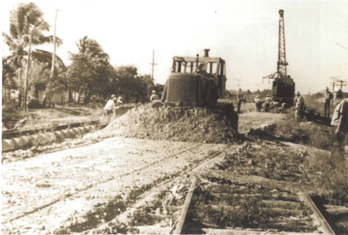
Реконструкция железных дорог на Кубе с укладкой железобетонных шпал. 1967 г.
