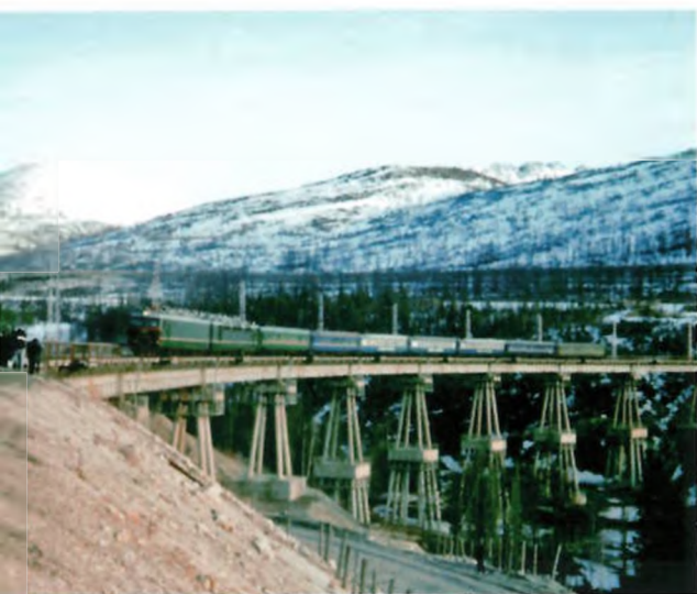
БАМ. Владук на западном спуске постоянной железнодорожной линии в обход Северо-Муйского тоннеля. 1989 г.
