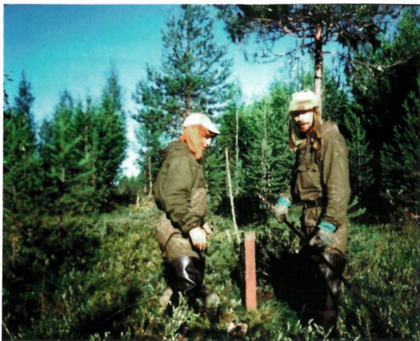
Закрепление трассы на подходе к мосту через реку Чулым. 1995 г.
