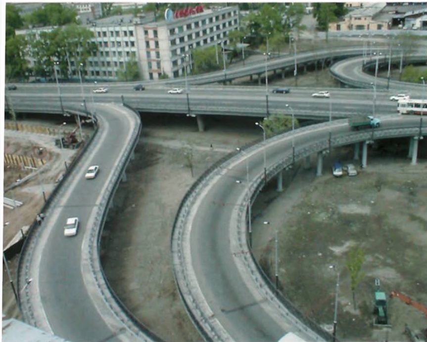
Автодорожная развязка в двух уровнях – улиц Карла Маркса и Ленинградской. Г. Хабаровск 2000 г.
