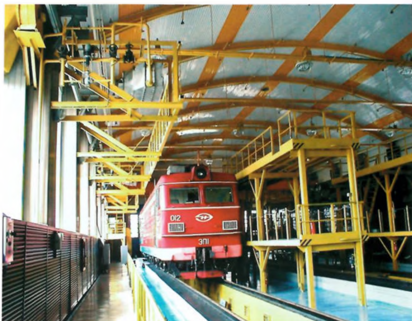
Строящееся депо электровозов в Хабаровске
