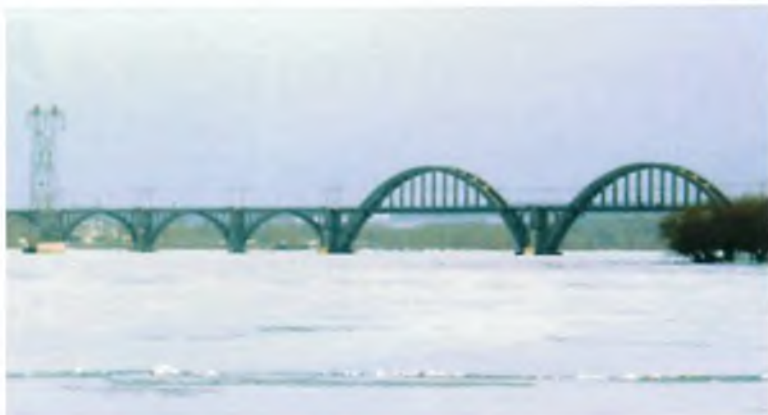
Мерефа-Херсонский железнодорожный мост через Днепр в Днепропетровске. Построен в 1932 г. Восстановлен в 1954 г.
