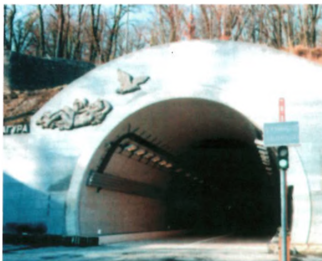
Мацестинский автомобильный тоннель. Краснодарский край. 2000 г.
