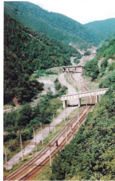
Сурамский перевальный участок железной дороги Сухуми–Тбилиси. Селеспуски через железную дорогу
