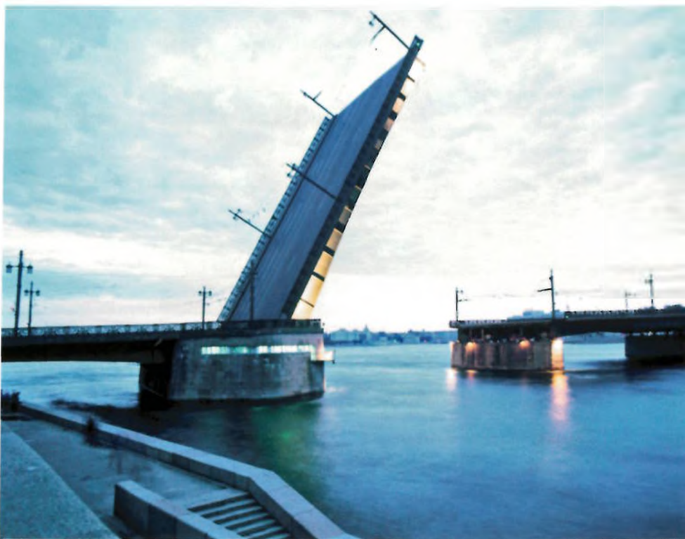
Разводной пролет Литейного моста через Неву после реконструкции. Санкт-Петербург. 1967 г.
