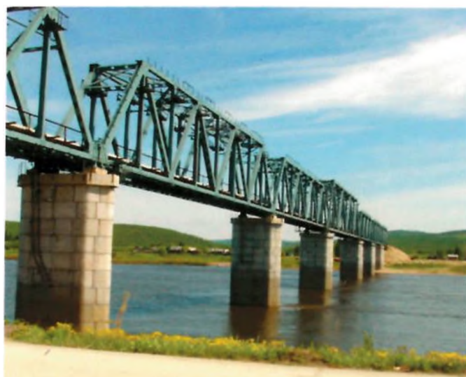
Мост через реку Алдан на железной дороге Беркакит–Томмот. 2001 г.
