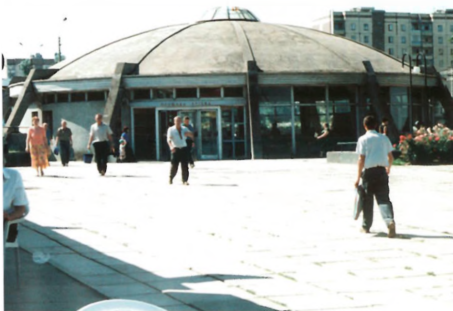
Кривой Рог. Скоростной трамвай. Станция «Площадь Артема». Вестибюль. 1986 г.
