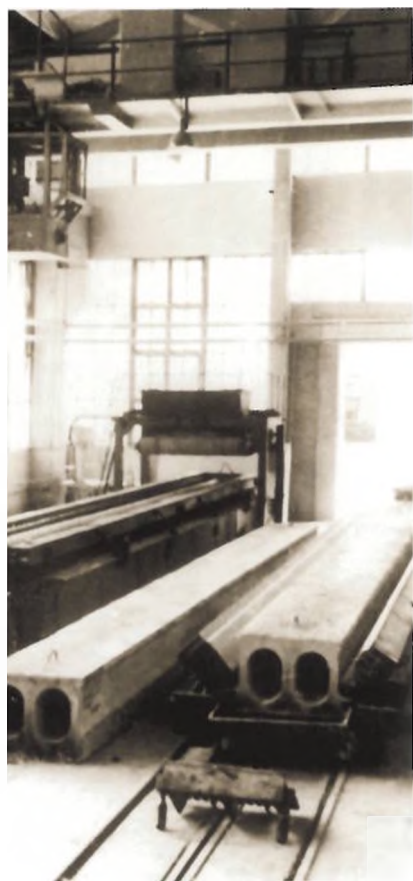
Технологическая линия изготовления пустотных плитных пролетных строений автодорожных мостов на Besланском заводе ЖБК. 1973 г.
