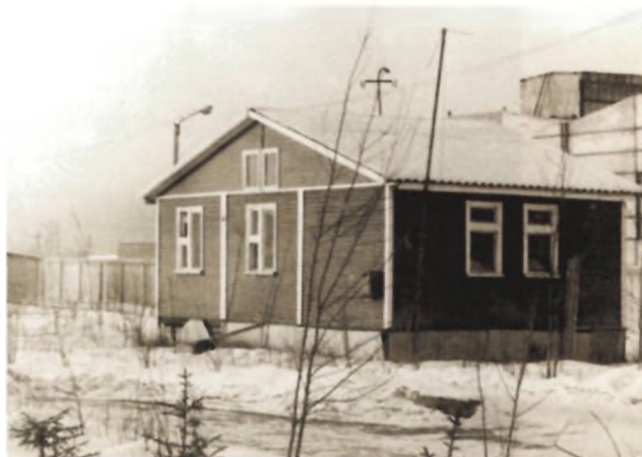
Одноквартирный жилой дом из контейнеров, изготовленных на Нижнеудинском заводе инвентарных зданий контейнерного типа
