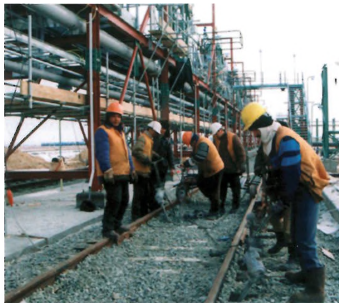
Прокладка путей к нефтеналивной эстакаде Тенгизского газоперерабатывающего завода. 2000 г.
