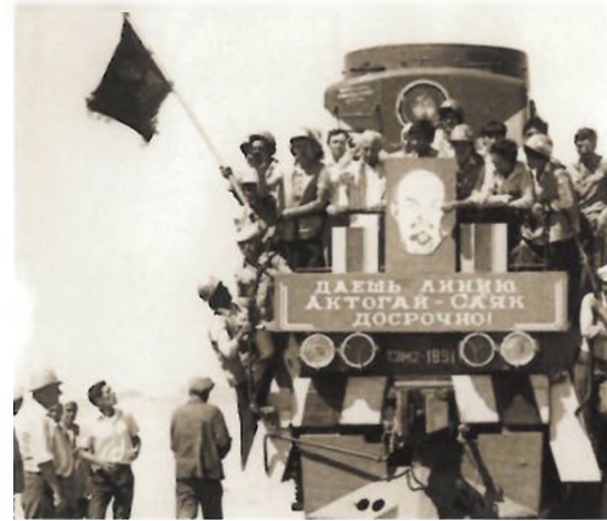
Первый поезд на железнодорожной линии Саяк-Актогай. 1988 г.
