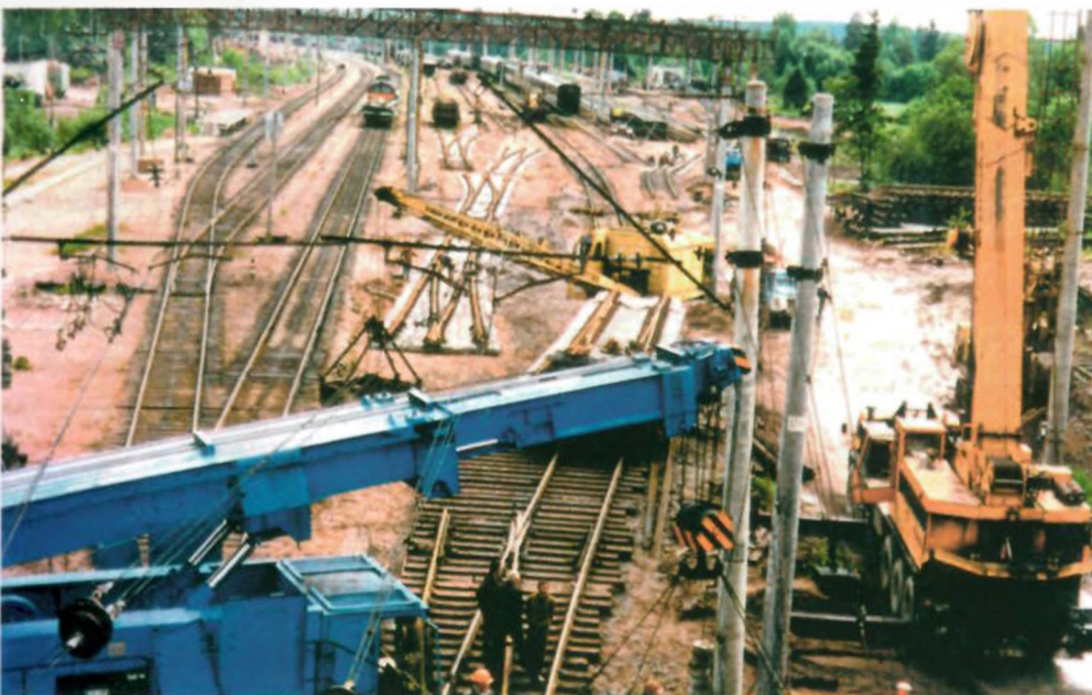
Строительство станции Бусловская Октябрьской железной дороги. Россия. 1995–1996 гг.
