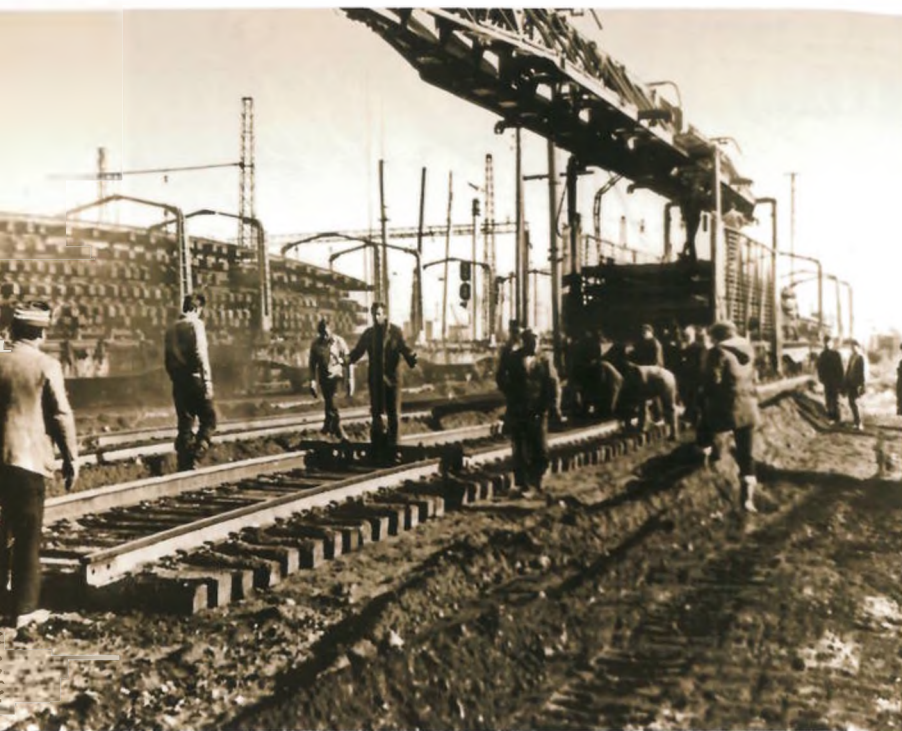
Укладка рельсов на одном из участков Транссиба
