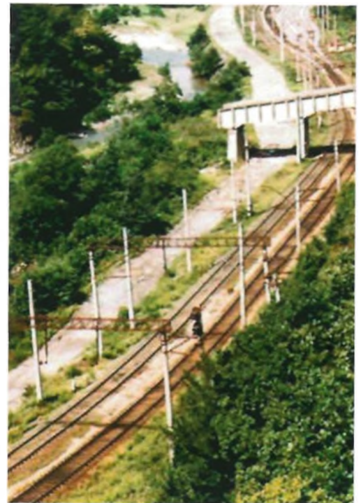
Строительство вторых путей на перевальном участке Зестафони–Хашурп. 1974–1976 гг.
