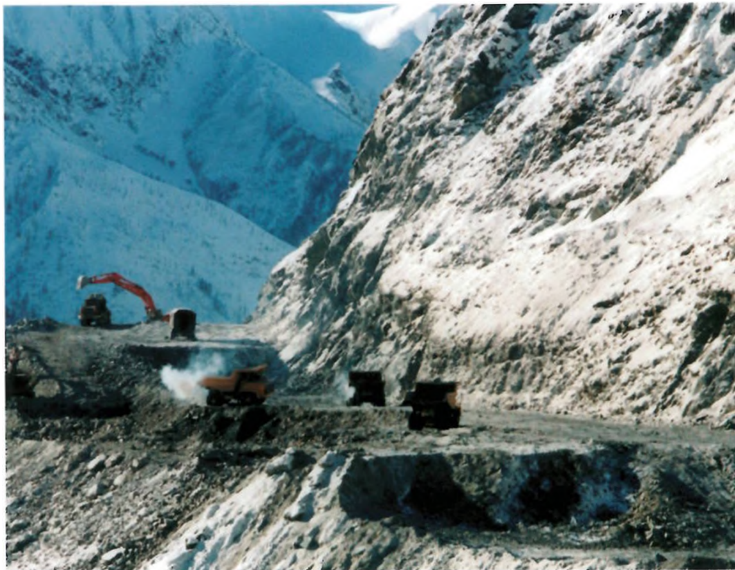
Строительство подъездного пути Чара–Чина. Читинская область. 2001 г.
