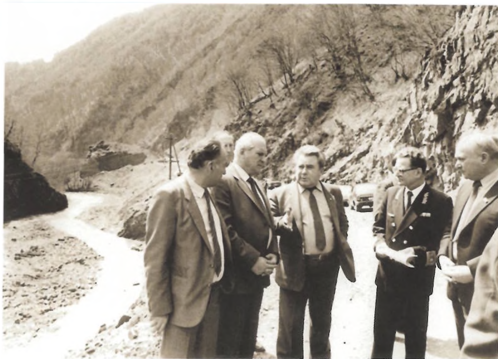
На строительстве Кавказкой перевальной дороги. 1984 г. В.Е. Бирюков, А.П. Гаркуша, Г.Х. Савченко, Л. Вардосанидзе
