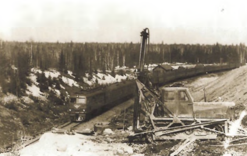
Буровой станок БТС-2. 1958 г.
