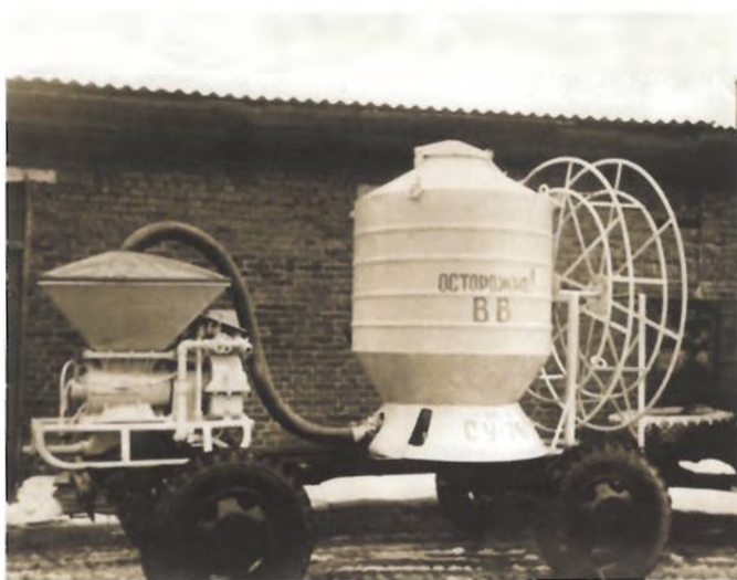
Транспортно-зарядная машина «Калуга». 1986 г.
