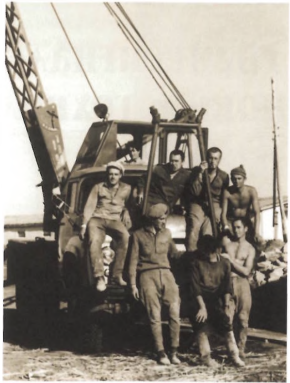
Строительство воздушной линии связи на объекте Кустанай–Урцкая, 1996 г.
