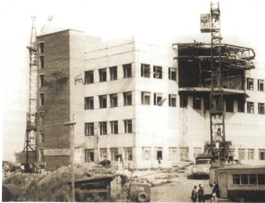
Строительство объединенного поста электрической централизации и мехгорки на станции Агрыз. 1984 г.
