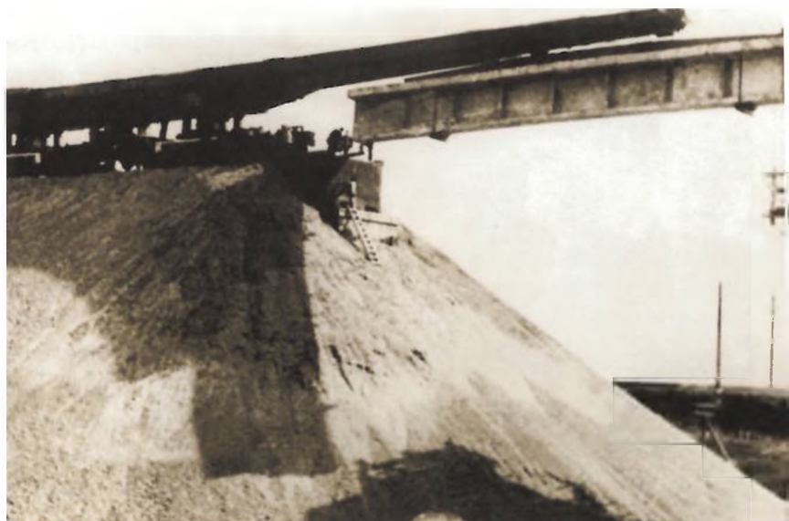
Кран ГЭПК-130 в работе. Производство освоено в 1964 г.
