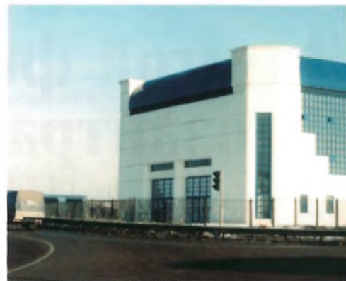
МКАД. Здание Мосгорсвета на шоссе Энтузиастов. 2000 г.
