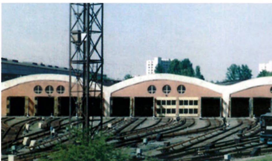
Депо метрополитена. 1985 г.
