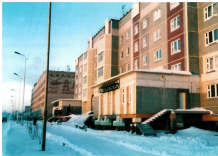
72-х квартирный дом в г. Лабытнанги. 2001 г.
