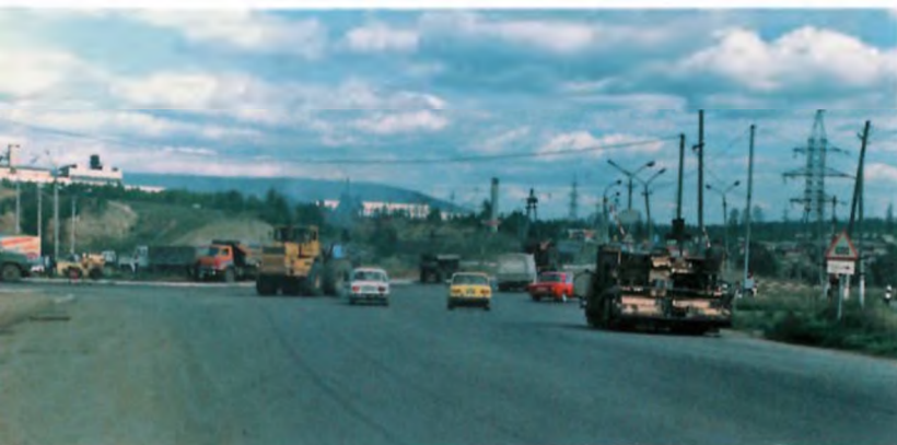
Расширение автодороги в г. Братске. 2001 г.
