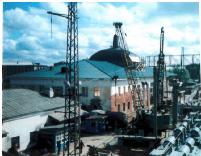
Вокзал на станции Тайшет. Работы по путевому развитию. 2001 г.
