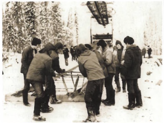
Укладка пути на западном участке БАМа. 1975 г.
