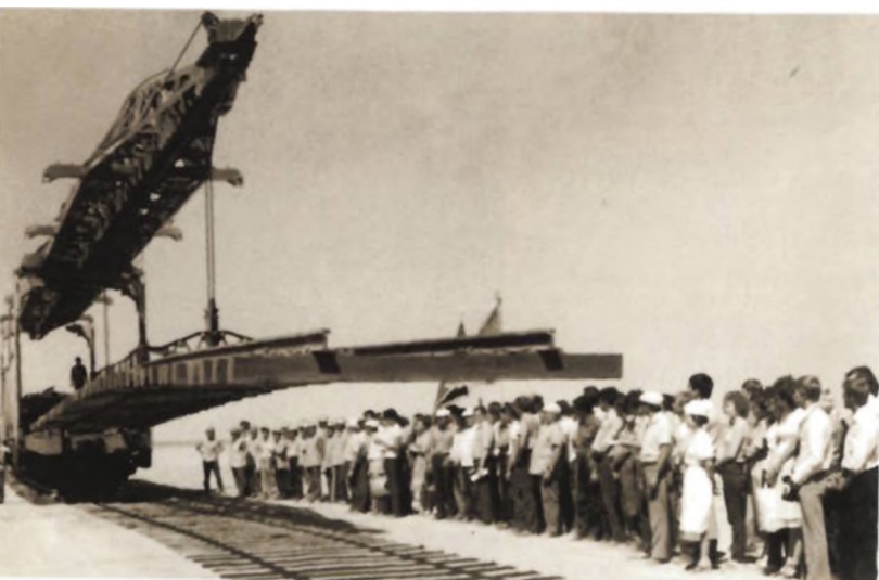
Решотинский ШПЗ. Цех наколки шпал
